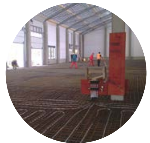
Sichtbare Betonkern- aktivierung im Baustatus
